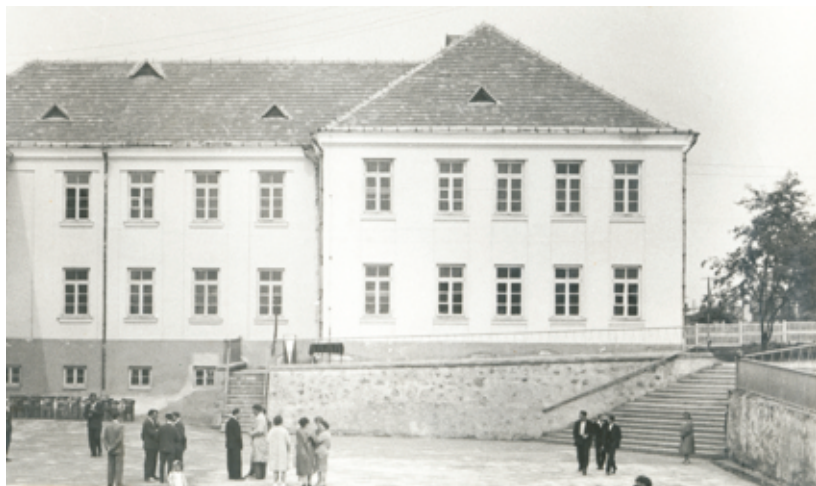
Budynek Liceum Ogólnokształcącego w Knyszynie. Fotografię wykonano prawdopodobnie w latach siedemdziesiątych XX w.
